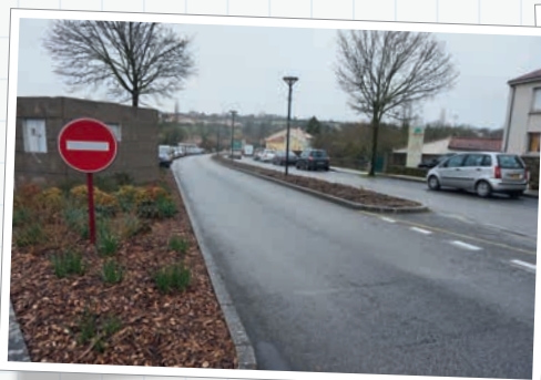
Travaux boulevard Rémi René Bazin
